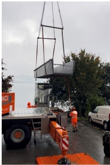
Livraison de la passerelle – octobre 2023
