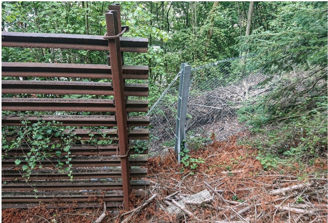
Figure 4: Ouvrages existants de protection contre les chutes de pierres
